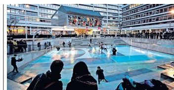
▲ Het Bentheplein kan 1,7 miljoen liter overtollig regenwater bufferen, het waterplein werd met bewoners en studenten bedacht.
