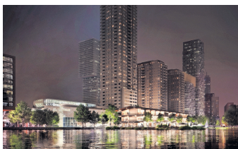
▲ Half augustus zal er een restaurant met terras opengaan, later volgt een drijvend buitenzwembad. Tussen kade en kantoor is een drijvend park gedacht van 50 meter breed. ARTIST IMPRESSION GILMOP
